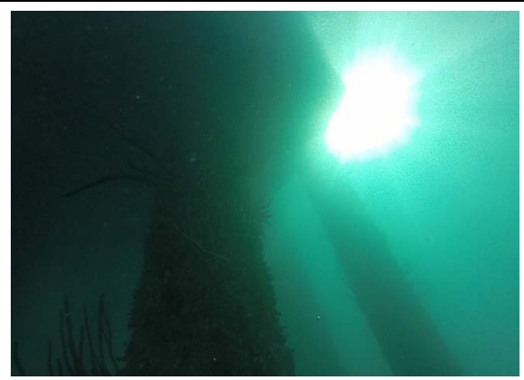
Fig. 3j - Piles under H-MD4
