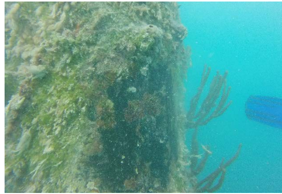
Fig. 1e - 1 st Level 2 inspection, Pile 1
